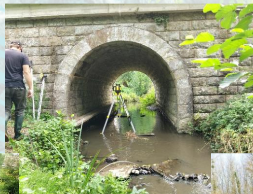
Diagnostic du franchissement d'un ouvrage sarthois
