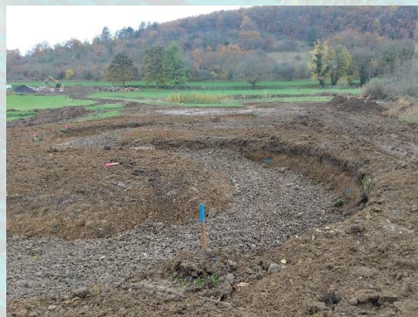
Terrassement du nouveau lit de la Sainte-Eugénie
