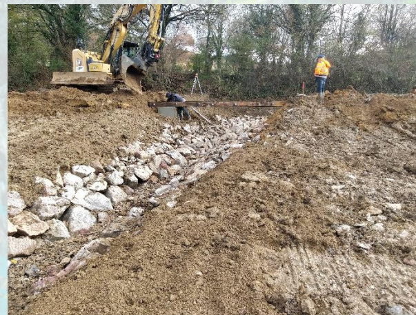
Installation de l'ouvrage de franchissement du talus
